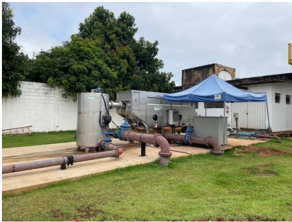
Figura TEC 6 – Tratamento de Lodo na ETA 2.
