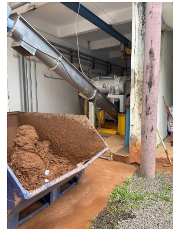
Figura TEC 6 – Tratamento de Lodo na ETA 2.
