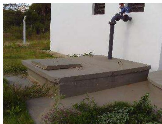
Figura 175 - Detalhe Tubulação de Sucção Adaptada (esq.) e da Tubulação de Recalque (dir.)
