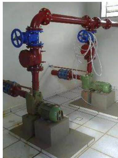
Figura 174 - Vista Geral da EEE (esq.) e Detalhe dos Conjuntos Moto Bombas (dir.)
