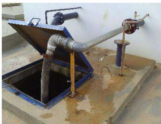
Figura 175 - Detalhe Tubulação de Sucção Adaptada (esq.) e da Tubulação de Recalque (dir.)
